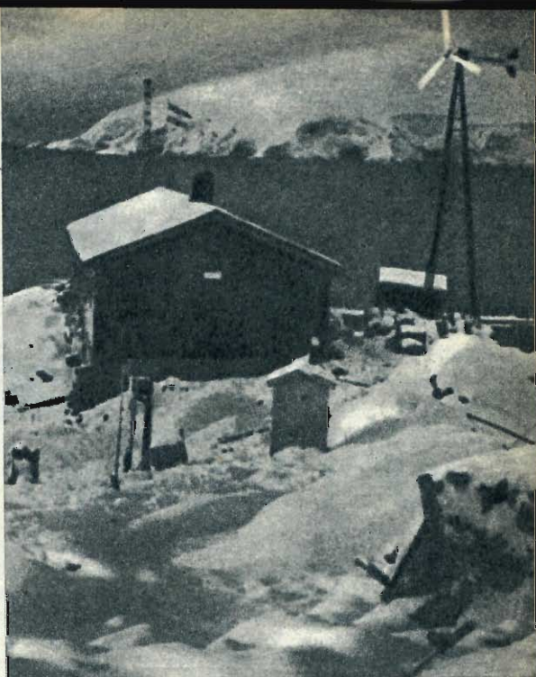
Questa è una delle installazioni fisse della « Polo Nord N. 4 »: la baracca, prefabbricata, pesa non più di 800 kg. ed è costruita in materiale plastico speciale. In primo piano la baracchetta dei servizi per la quale è stato fatto uno speciale scarico attraverso lo strato del ghiaccio, ed a destra la torre della centrale elettrica a vento.
